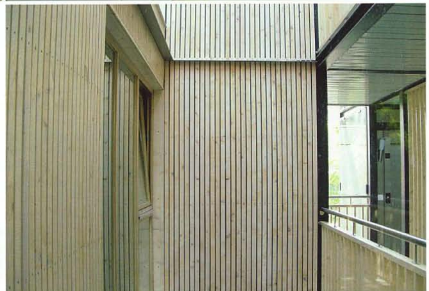
Les puits de lumière séparant la coursive de la baie vitrée d'un appartement donnent une certaine intimité aux habitants.
