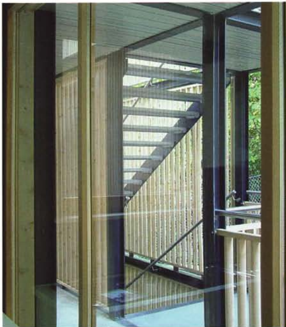
Du bois et de l'acier pour les escaliers, et des grandes baies vitrées pour un généreux éclairage naturel.
