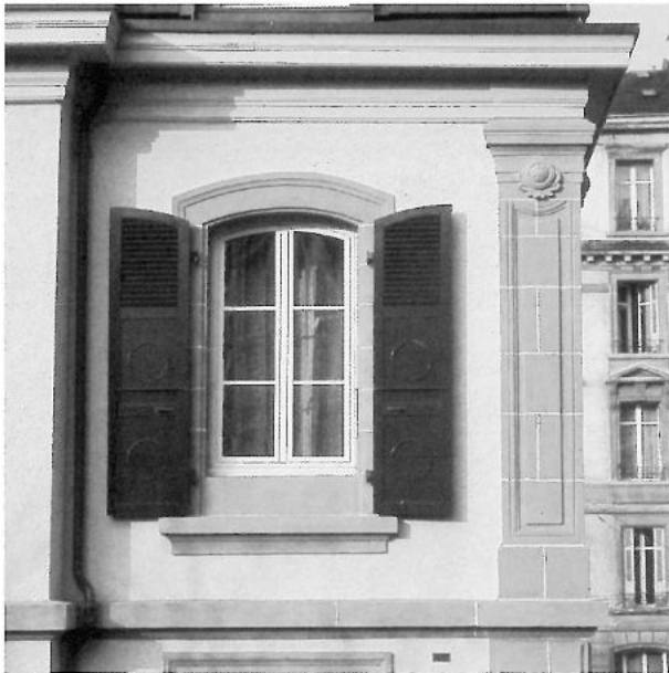
RÉFECTION DES ÉLÉMENTS EN MOLASSE
