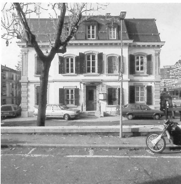
IMM. RUMINE FAÇADE EST
