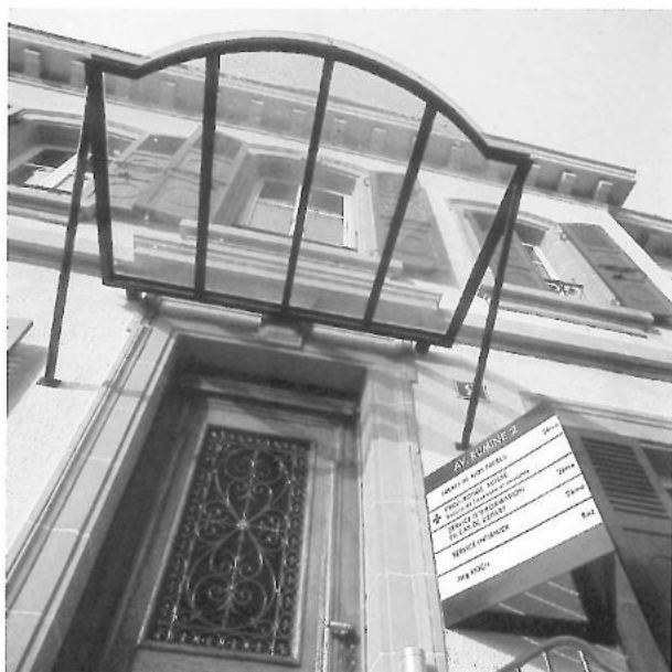
MARQUISE ET ENSEIGNE
