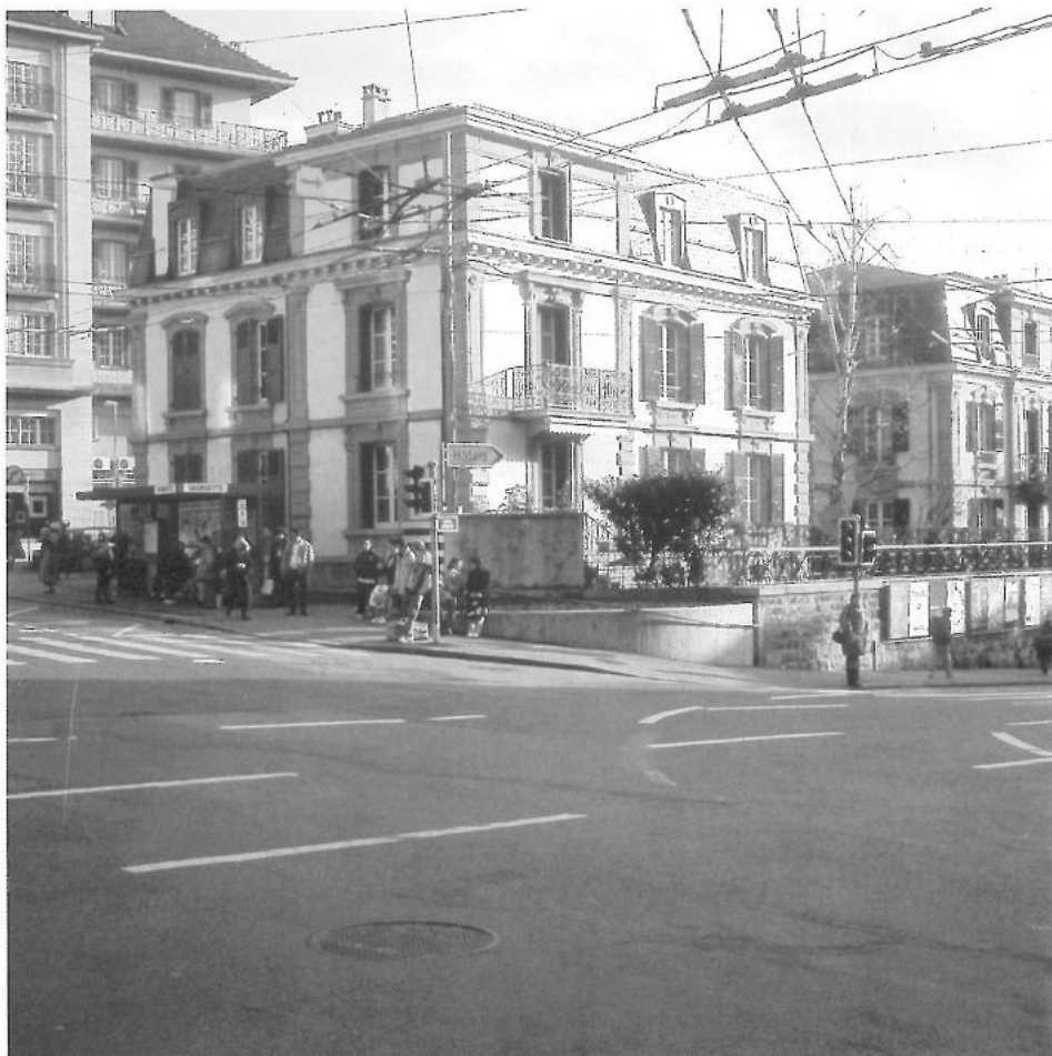
IMM. RUMINE 2 FAÇADE OUEST
